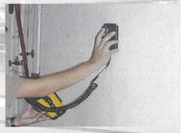
Cover Meter Detection 混凝土面層厚度勘察，為混凝土內的鋼筋定位，並量度鋼筋的直徑
